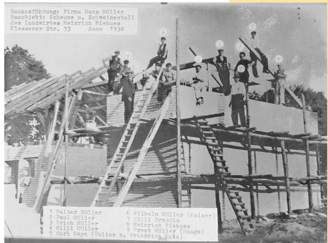
Bau der Scheune bei Siedler Niehues - 1938
